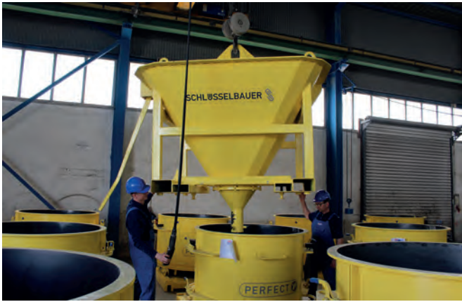
Бетонирование осуществляется посредством бады объемом 2 м 3
